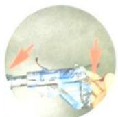
Narovnejte kabel (instalace)
