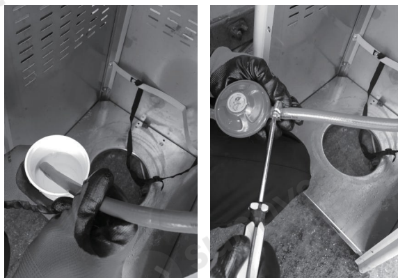
Prawidłowe podłączenie węża i regulatora do butli gazowej.
