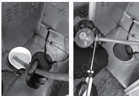
Správne pripojenie hadice a regulátora k plynovej bombe.
