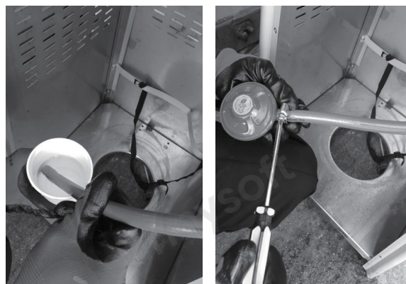
A tömlő és a szabályozó helyes csatlakoztatása a gázpalackhoz.
