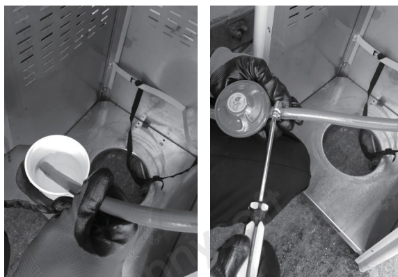
Správné připojení hadice a regulátoru k plynové bombě.
